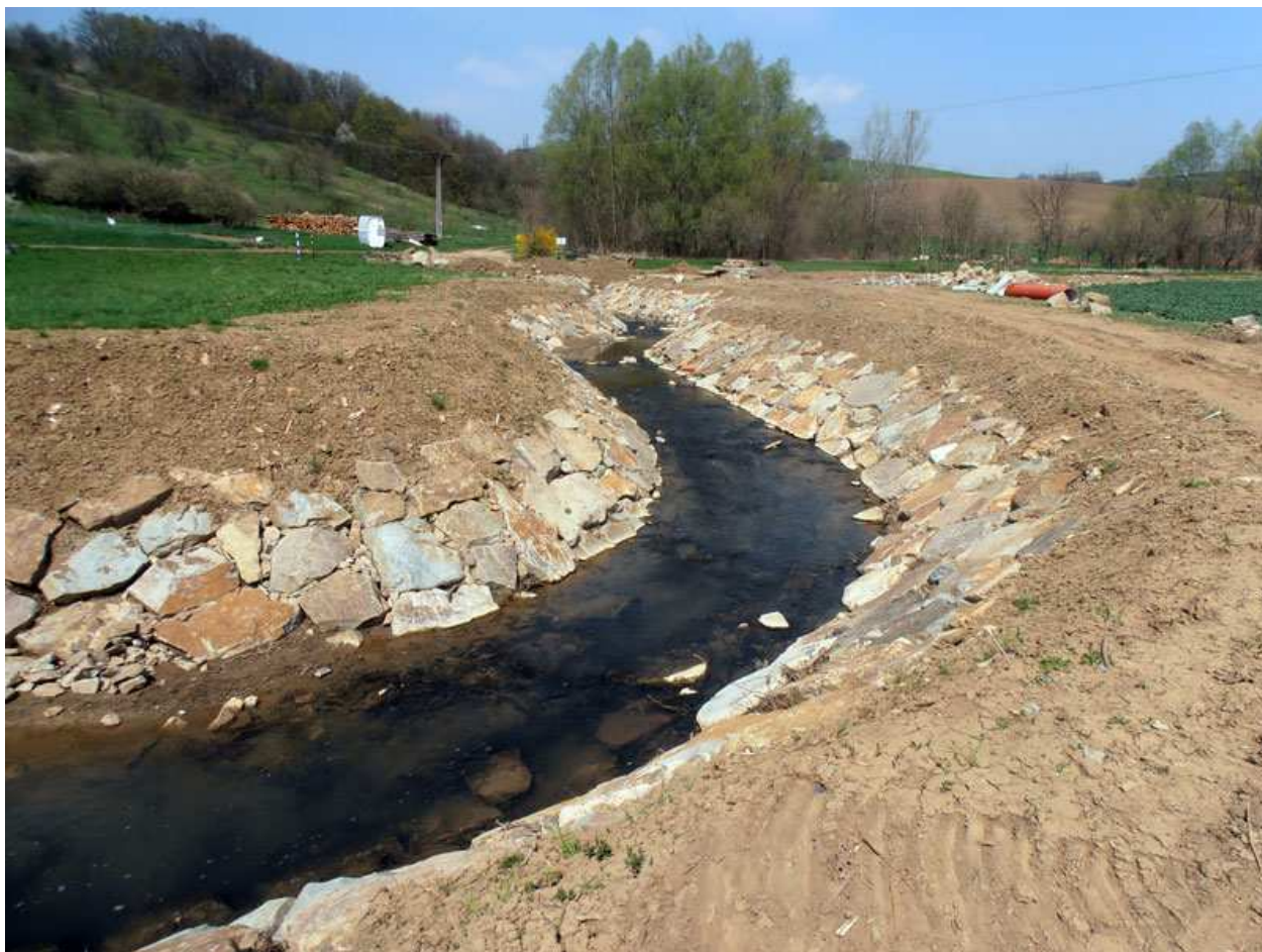
Vzorová ukázka kamenné rovnaniny s vyklínováním
